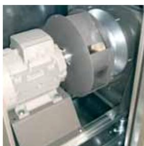
Вентиляторная секция – самый важный компонент в определении размеров воздухообрабатывающего агрегата.
